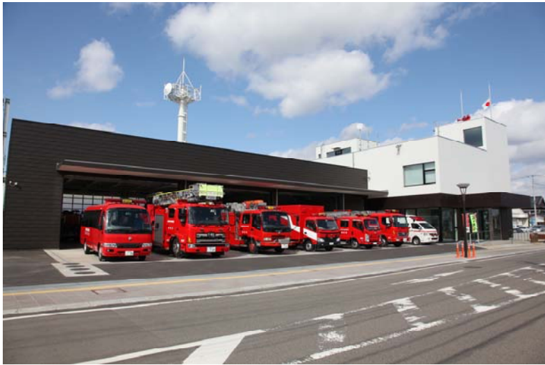
消防本部・中央消防署
