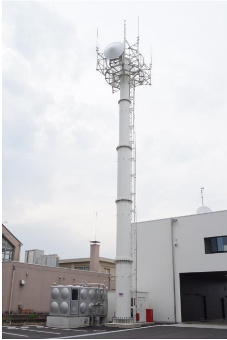
消防本部無線基地局
