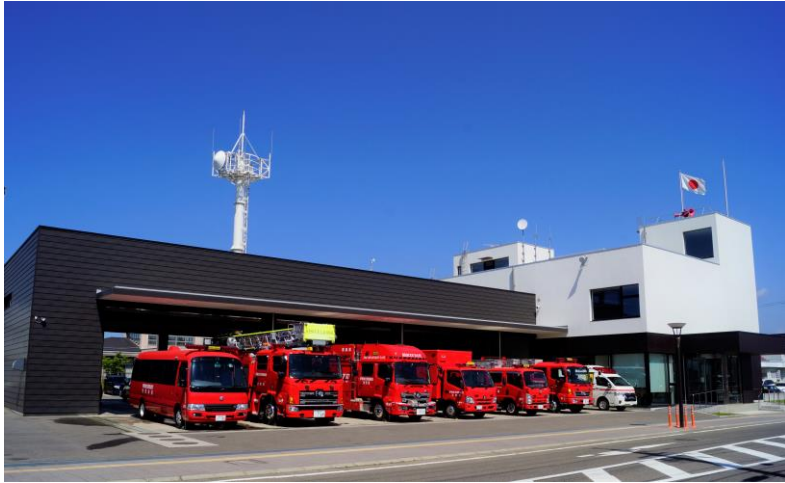
消防本部・中央消防署
