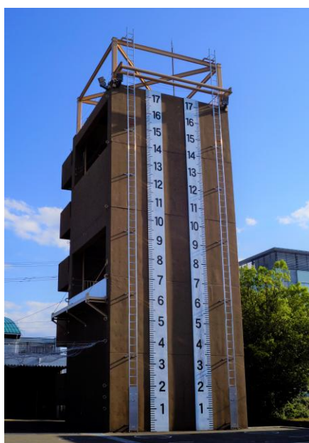
高所訓練塔 (A 塔)
